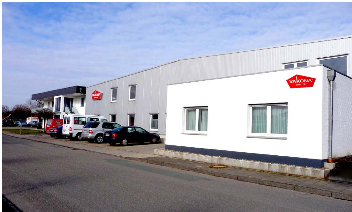
VAKONA-Gebäude im westfälischen Liengen.
